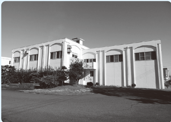
衛生施設外観
